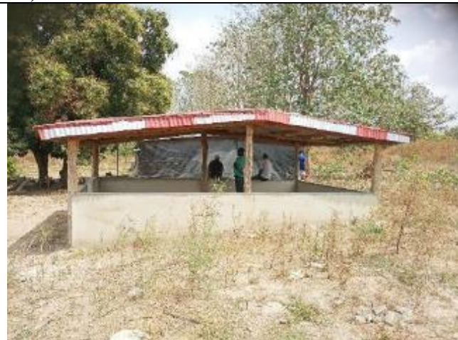
Photo 4 : Hangar de repos en tôles dans l'emprise de l'amenée d'électricité (entre les poteaux 12 et 13)
