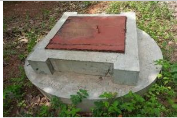
Photo 12 : Puits présent sur le site et appartenant à Monsieur SILLAH Saliha, détenteur du TF n°1885
